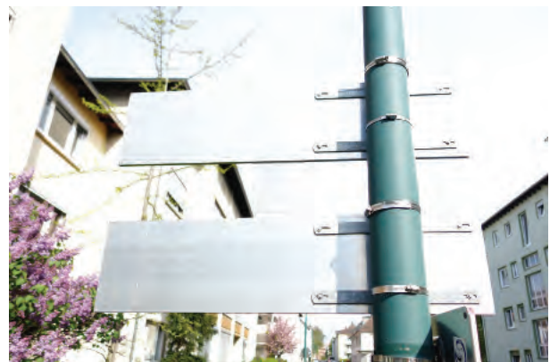
Abb. 6-4: Rückseitige Schildermontage
