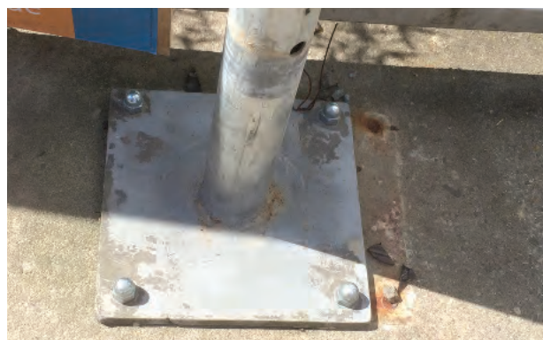
Abb. 6-12: Einbau mit Bodenhülse für befahrbare Flächen
