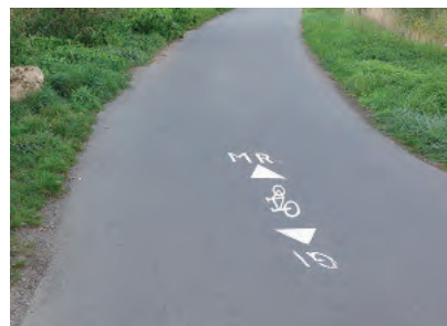
Abb. 4-17: Markierung mit Ortskennung im Flurbereich
